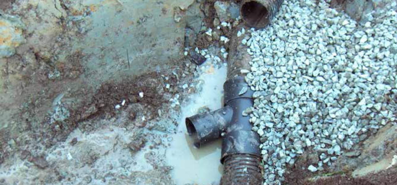
Singel er et godt egnet filter der ny og gammel grøft møtes. Singelen kunne med fordel vært finere (2-8 mm). Foto: NLR.
