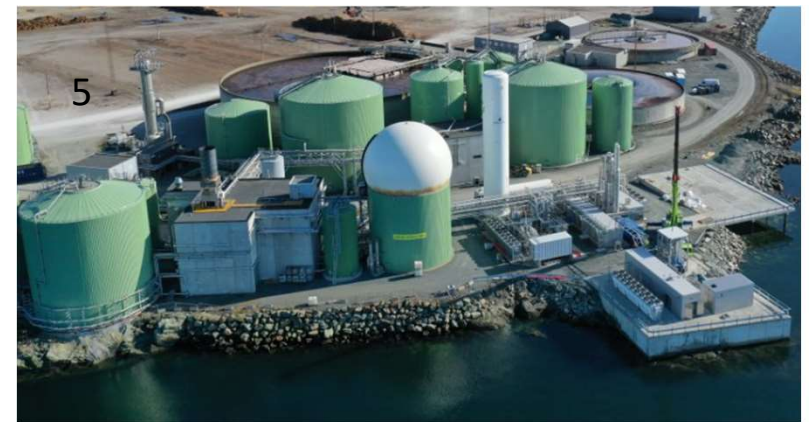
Biokrafts anlegg på Skogn i Trøndelag. Foto: Biokraft.
