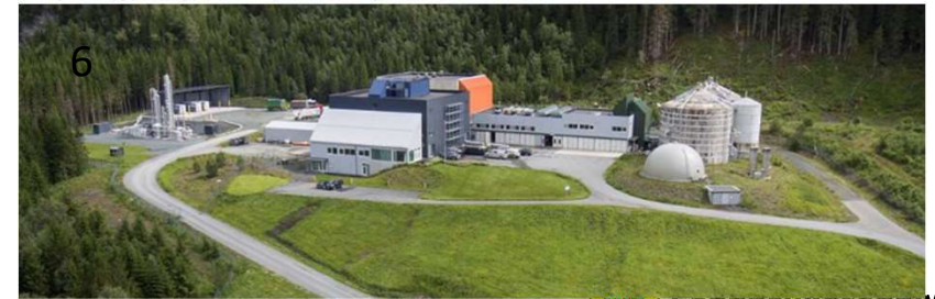
Ecopro i Verdal håndterer 40.000 tonn substrat årlig. Foto: Ecopro
