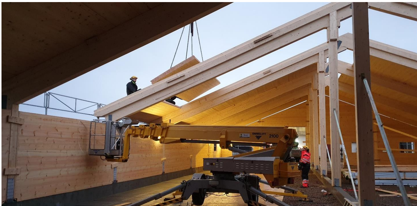
MÅLRETTET: Klimasmart driftsbygning i massivtre under oppføring i Nordland. (Foto: Ketil Are Edvardsen)
