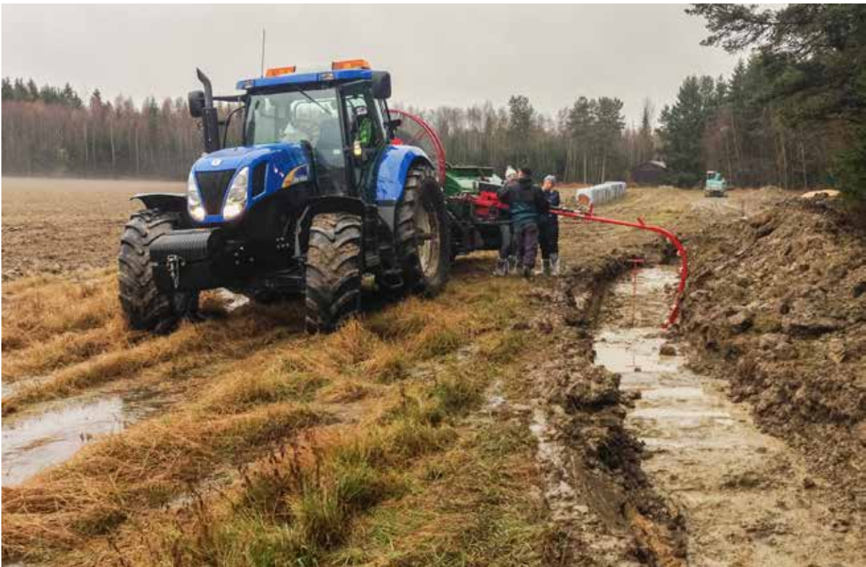
Tiltak: Drenering og vedlikehold av dreneringsanlegg er et viktig (klima)tiltak.
