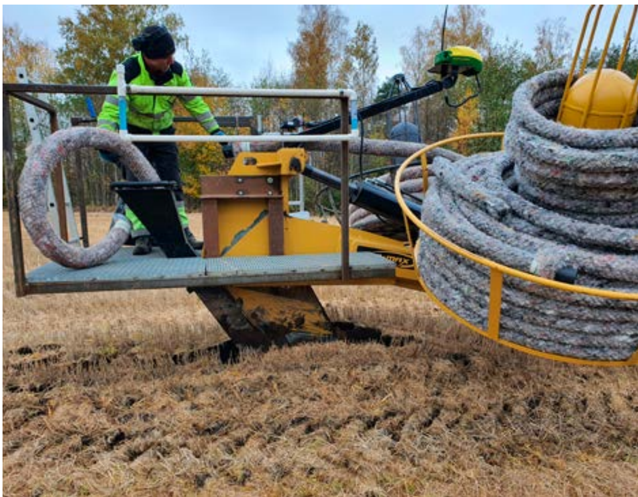
Filter: Ved drenering brukes det et filtermateriale. Det er viktig å bruke riktig filter. / FOTO: Øyvind Akselsen
