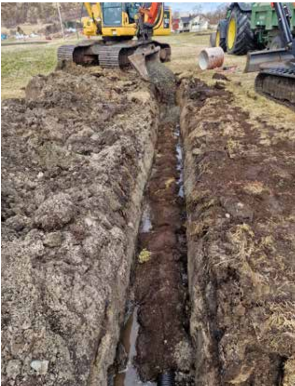
Drenering: Paret drenerer 70 dekar dyrka areal. Dette er et viktig tiltak for å høste større avlinger med lavere utslipp. / FOTO: Privat
