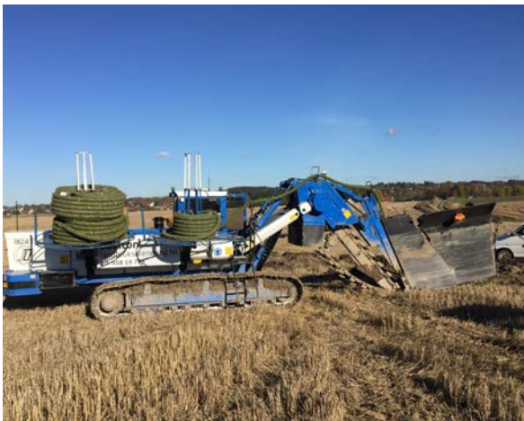
Sørg for å ha gode avtaler på plass før arbeid med grøfting eller annen transport over jordet starter. Foto: ukjent.
